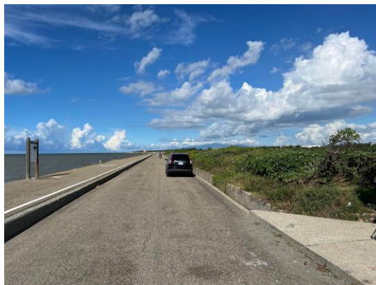
堤防道路現況
