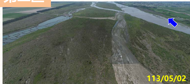
40號越堤路 上下游
