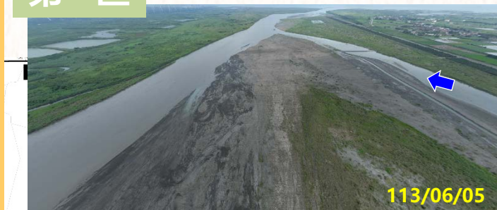
7號越堤路 上下游
