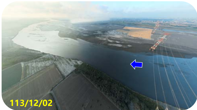
第三區 跨河電塔 下游
