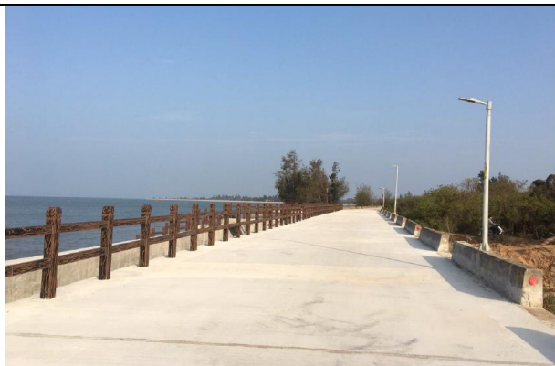
日期：109 年 位置：(TWD97) X：179289, Y：2705670 概述：區排北段路面完工情形
