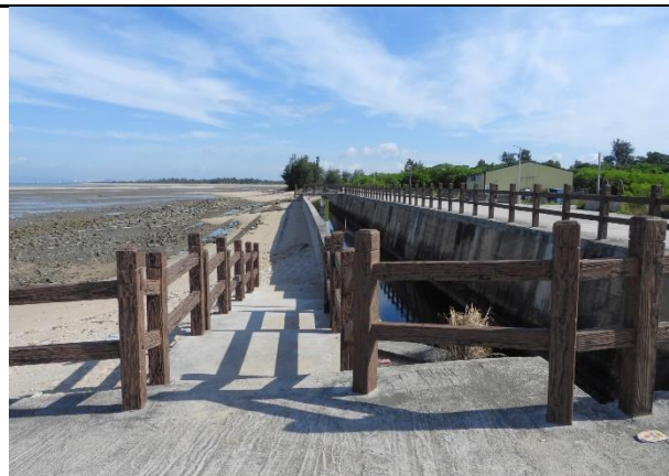
日期：113 年 7 月 11 日 位置：(TWD97) X：179289, Y：2705670 概述：行人階梯與溝渠維管階段現況
