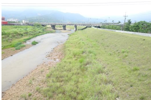
110/05/14 左岸植生恢復中
