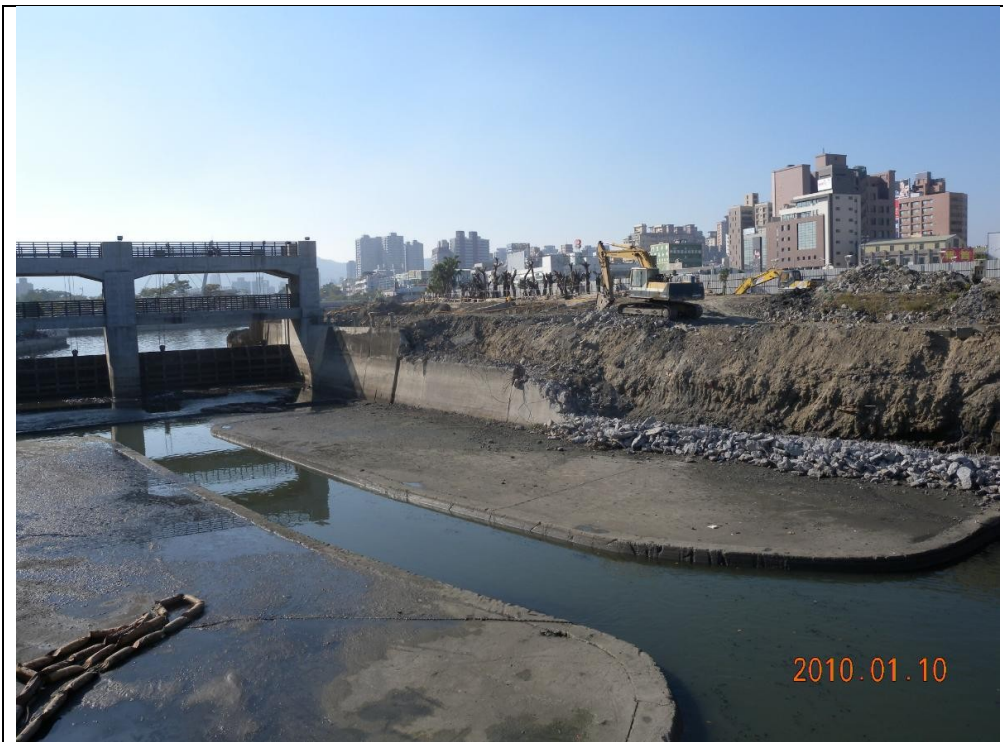
愛河之心上游河道護岸改建工程(2010.01.10)
