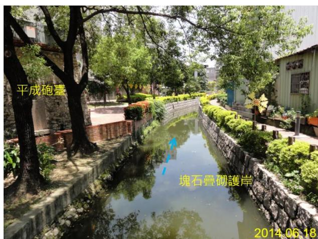
除了與第一期工程同樣將渠道採分層設計，明渠段排放清水作為水域環境營造，污水由截流溝集中收集至污水處理廠處理，而護岸以塊石疊砌之生態工法，增加透水性與透氣性，活化護岸表面，並因天然石材與環境自然融合，更可喚回舊有護城河之歷史肌理。
