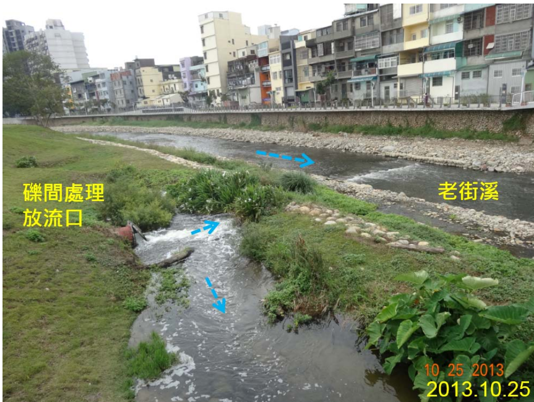
礫間接觸曝氣氧化設施處理後的水源放流至老街溪(攝/蘇郁文)
