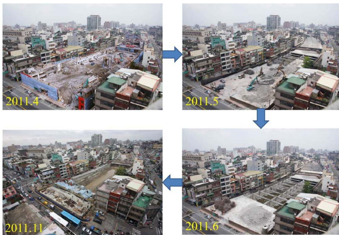
老街溪商場拆除過程 (桃園縣政府水務局, 2011)
