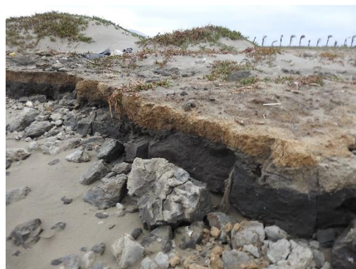
清淤土堆置區現況
