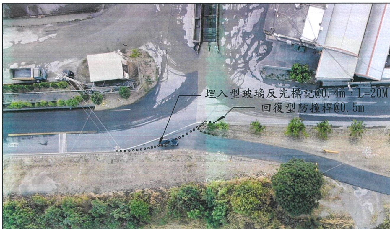
芬園堤防越堤路改善-台崧混凝土公司前 (烏溪越堤路編號62號)
