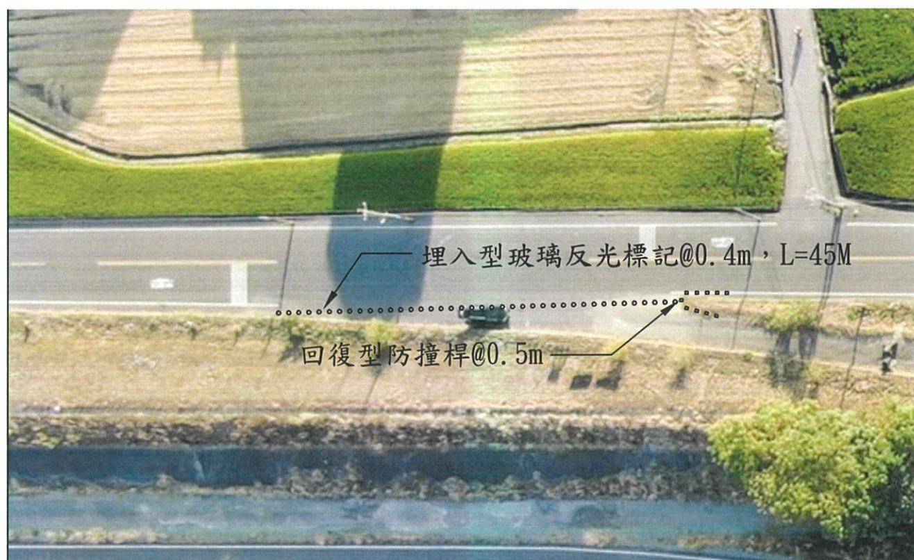
芬園堤防越堤路改善-溪尾國小前 (烏溪越堤路編號66號)
