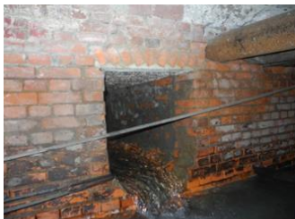
圖 D：忠義路道路下方，溝體北側注入之自然水體。
