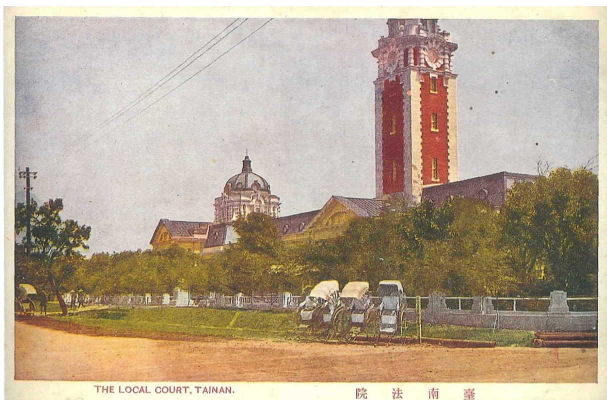
圖 6 《臺南法院》老照片
