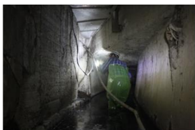
圖 G：台水六區處之水泥箱涵
