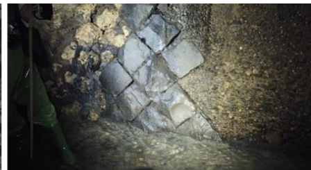
圖 F：舊臺南地方法院人行道下方箱涵交界處之黑色玄武岩，左側為日治前之硃砧石、右側為民國後水泥化之箱涵
