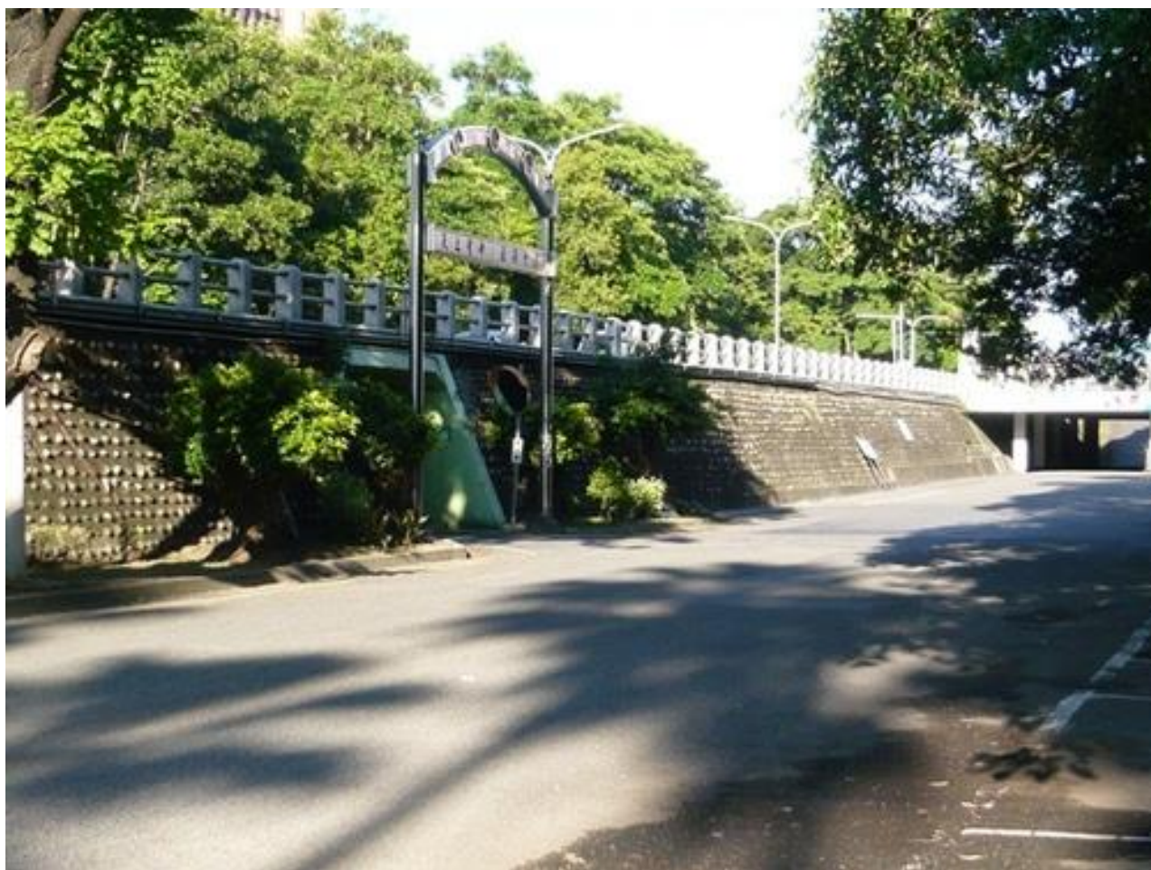
圖 29 文元溪護岸河階現況
