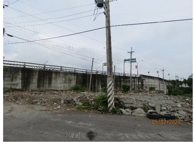
【紅葉工區】保全對象「台9線東側的大樹群」已移除。
