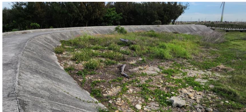
不同階段施作的海堤混凝土設施物，應考量濱海空間特性提供生長空間種植栽濱海地被植物
