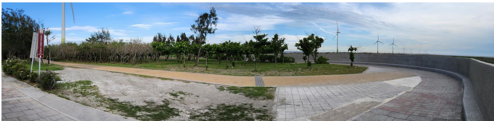
龜殼東北角海堤加高而內部因地形高程，內水易積淹造成防風林多次種植生長不佳表土裸露
