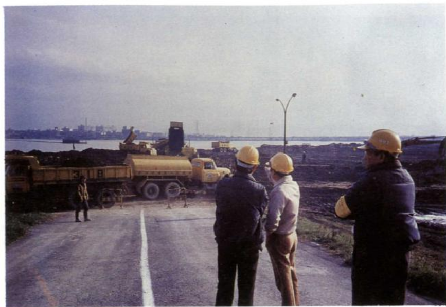
疏洪道堤防施工中
