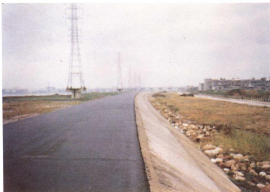
蘆洲堤防施工後
