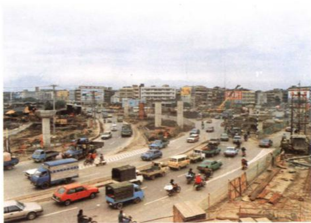
二重疏洪道高架橋施工中
