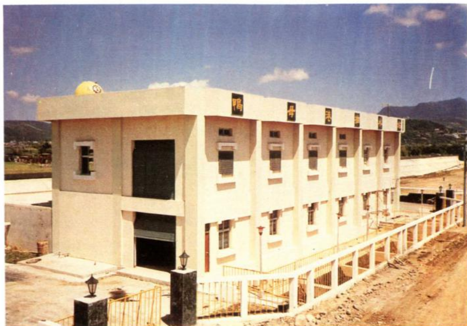
鴨 母 港 抽 水 站
