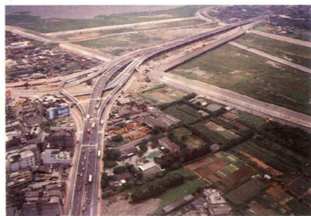
二重疏洪道高架橋鳥瞰
