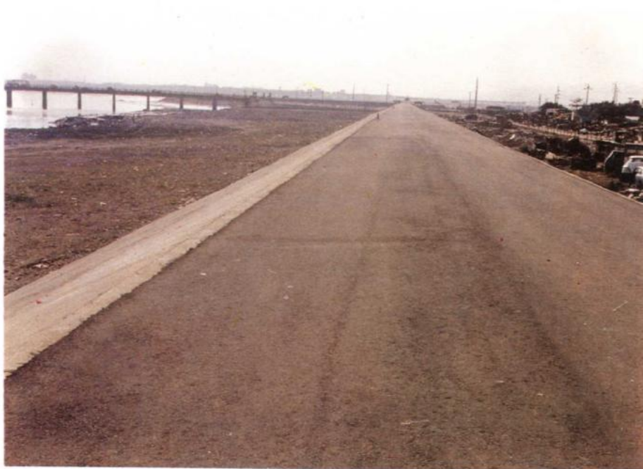
三重堤防中興橋處施工後
