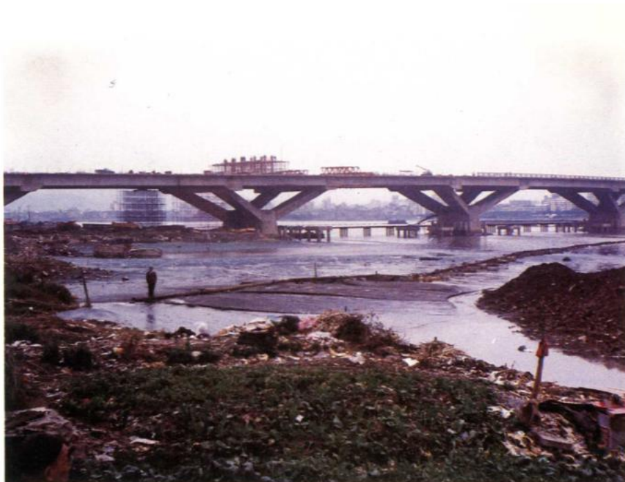
三重堤防忠孝橋處施工前
