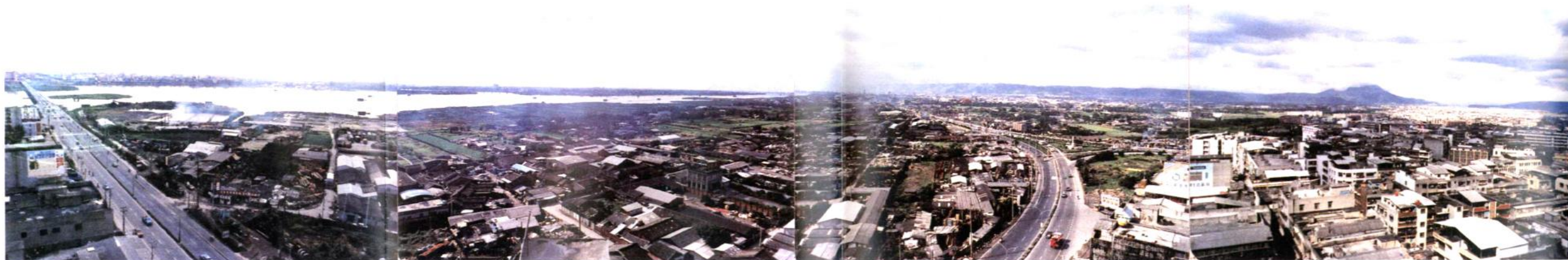
二重疏洪道施工前
