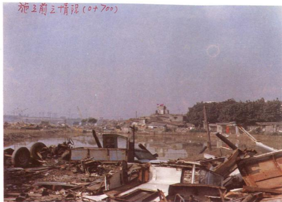
三重堤防中興橋處施工前
