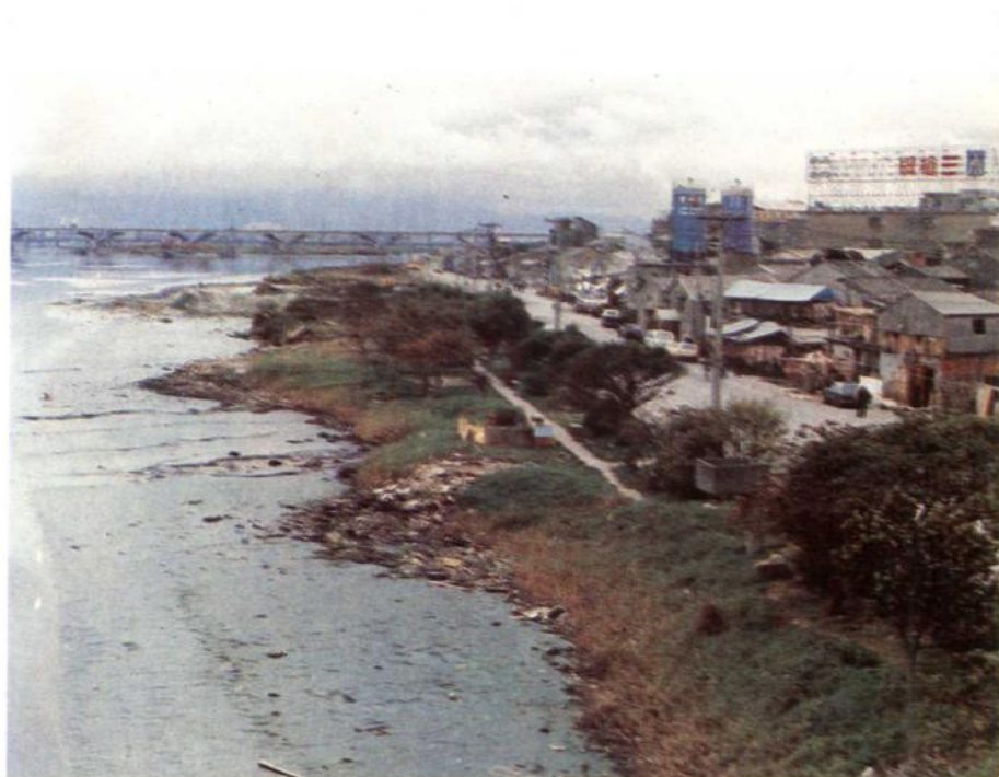
三重堤防台北橋處施工前
