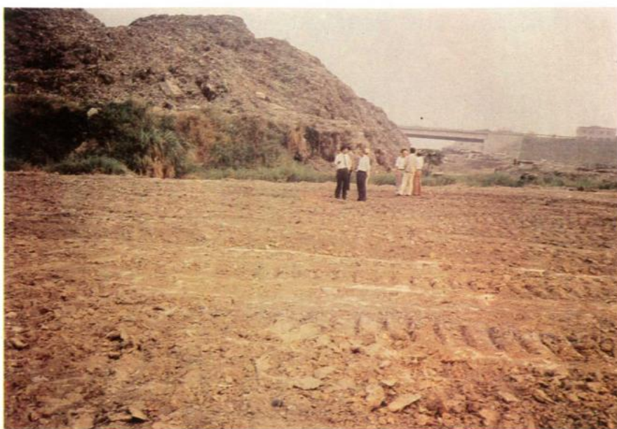
三重堤防高速公路旁垃圾山施工前
