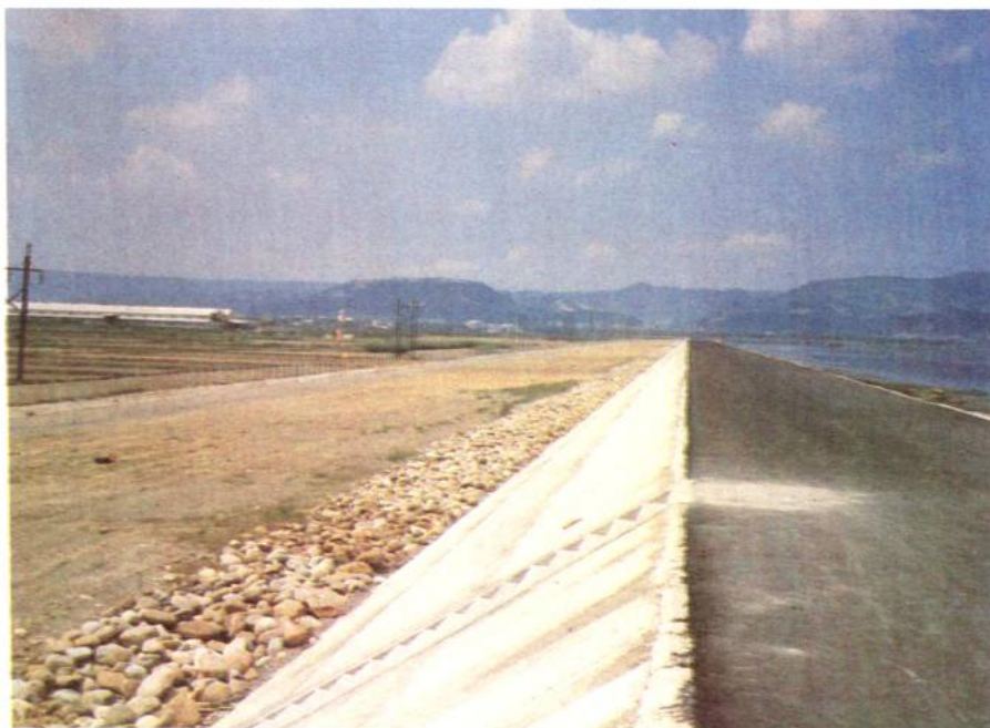
蘆洲堤防施工後
