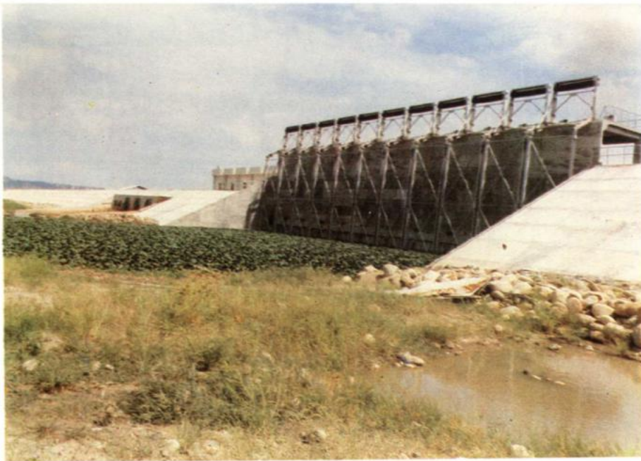
鴨母港排水閘門施工後
