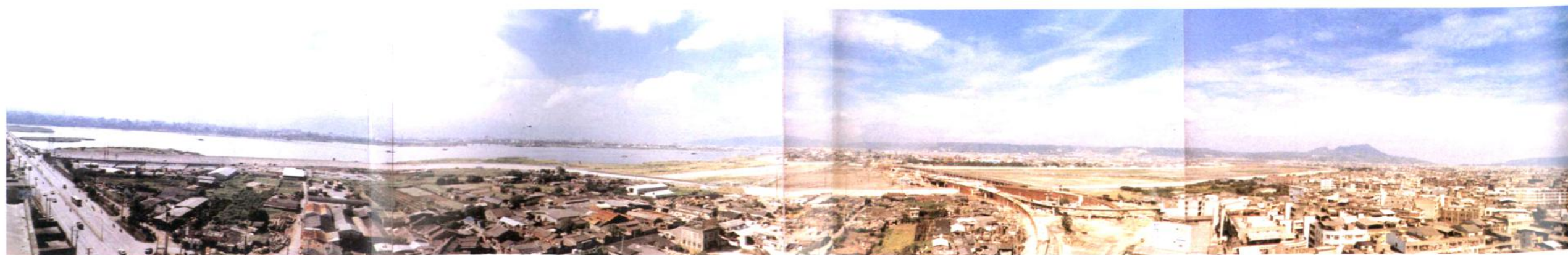
二重疏洪道施工中
