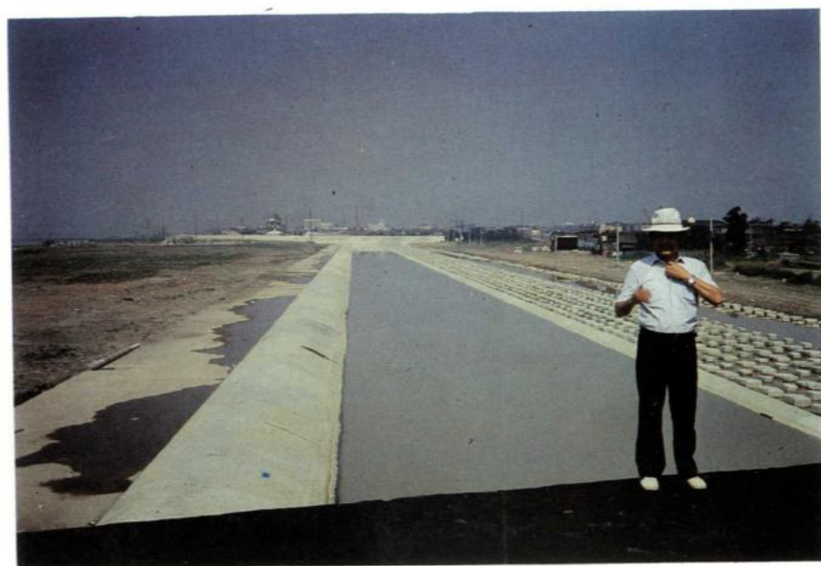
疏洪道入口固定堰完工照
