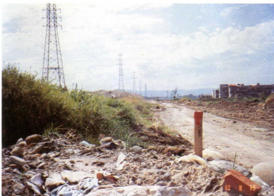
蘆洲堤防施工前
