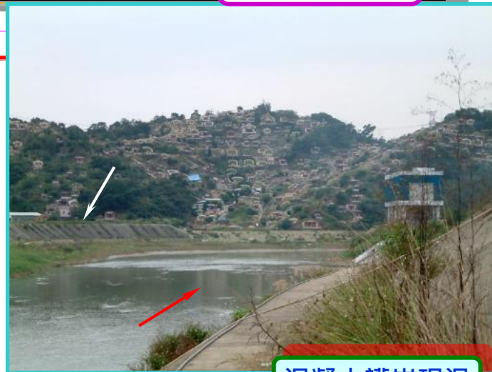
混凝土護岸現況
