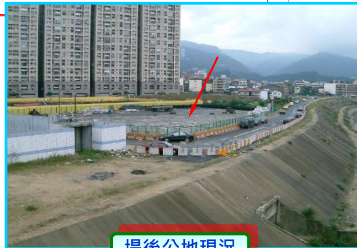
堤後公地現況
