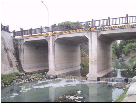
芭樹埤排水出水口
