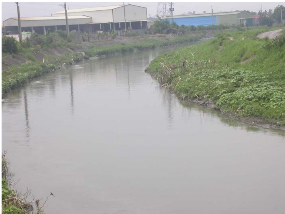
照片 3.4-14 仁德橋空間利用情形
