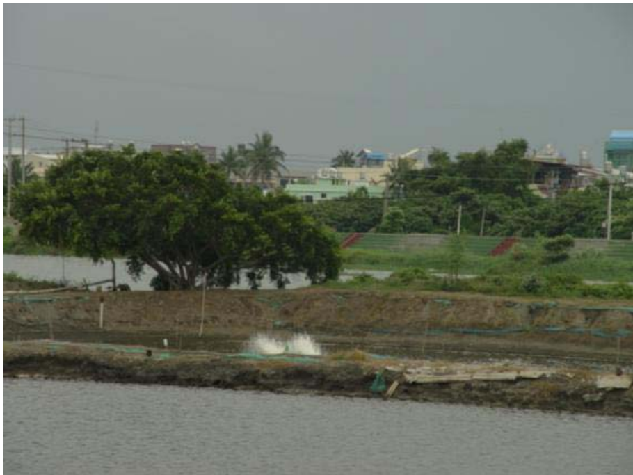
照片 3.4-6 東港大橋空間利用情形
