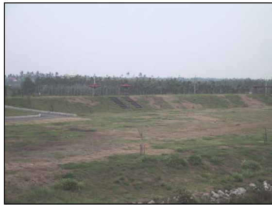
龍東二號橋段堤防
