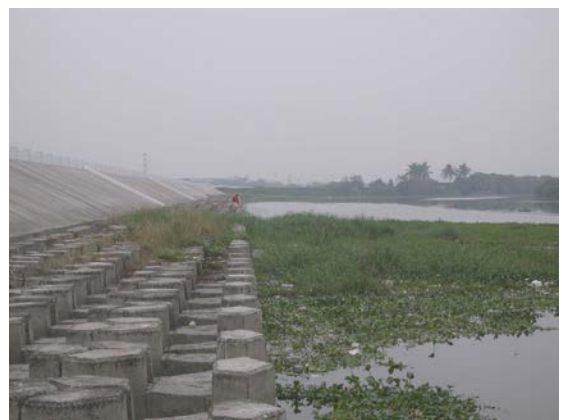
龍港大橋之魚類調查作業
