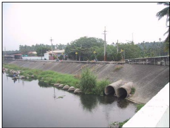
龍東橋護岸及排水口
