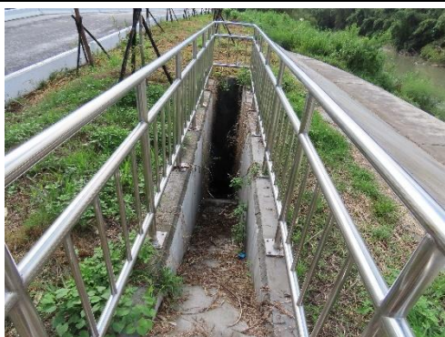
生態保育措施 【完工】
