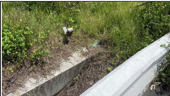
生態保育措施 【完工】
