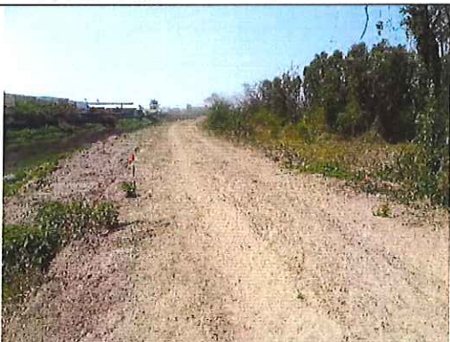
右岸施工便道 (拍攝日期:110.2.23)
