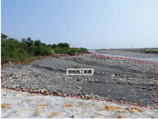
圖 2 工程位置環境現況
