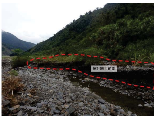
圖 2 預計施工範圍環境現況
