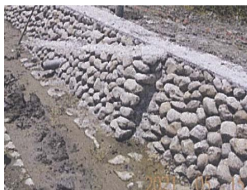
設置動物坡道，其坡度約 1：3 110.05.15
