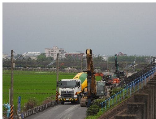
工區下游棲地環境現況 110.03.31
