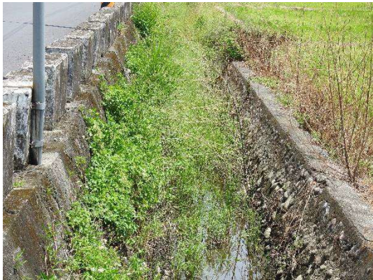
圖 2 側溝護岸現況
