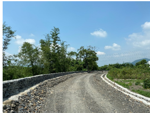
以砌石方式施作側溝
