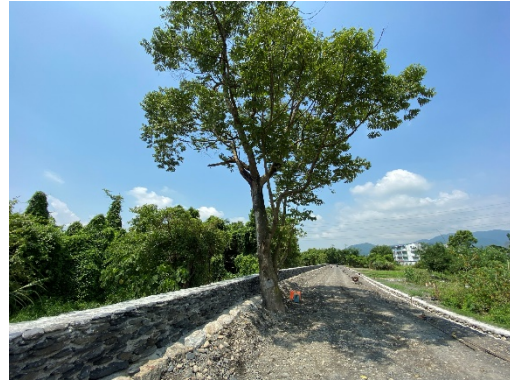
施工便道兩側喬木進行保護
