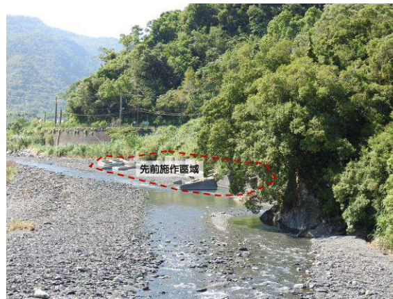
圖 3 上游端已施作區域
