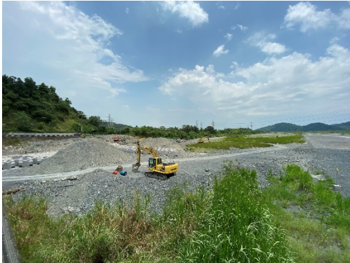
工區上游棲地環境現況 110.05.24
