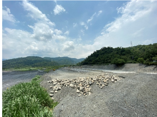
工區下游棲地環境現況 110.05.24
