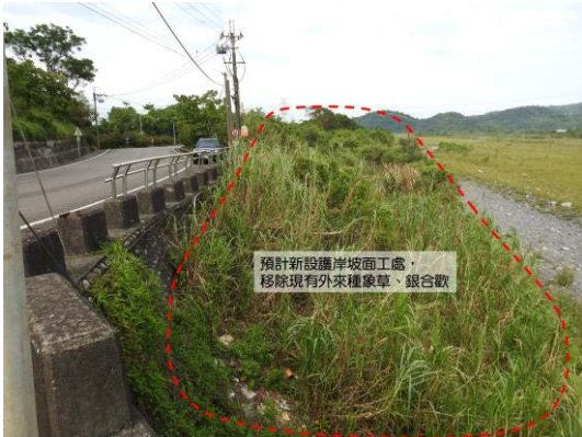
圖 2 新設護岸坡面工、移除外來種
