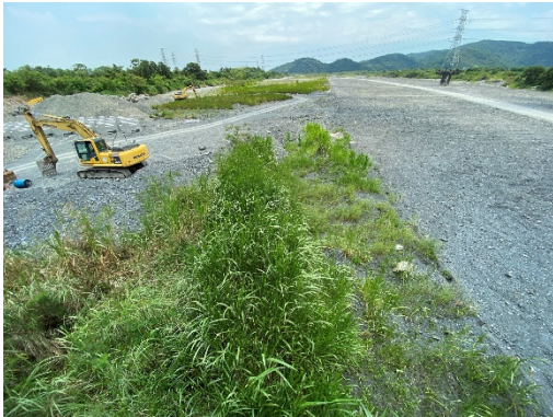
施工便道選用既有道路(下游端前期疏濬作業之道路)
