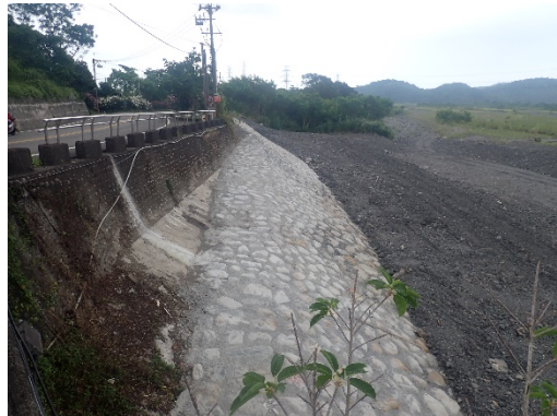
新設護岸（緩坡漿砌石）110.07.29
