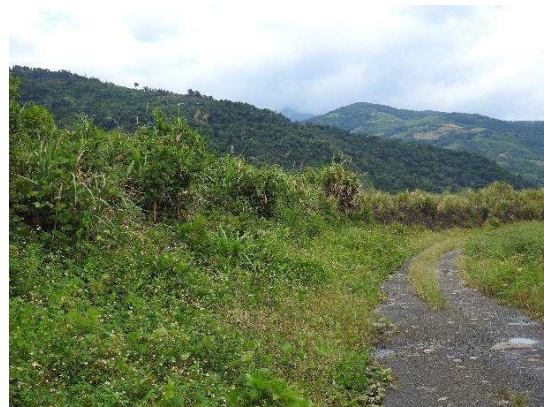
瑪崙二號堤防現況-高草莖草叢環境
