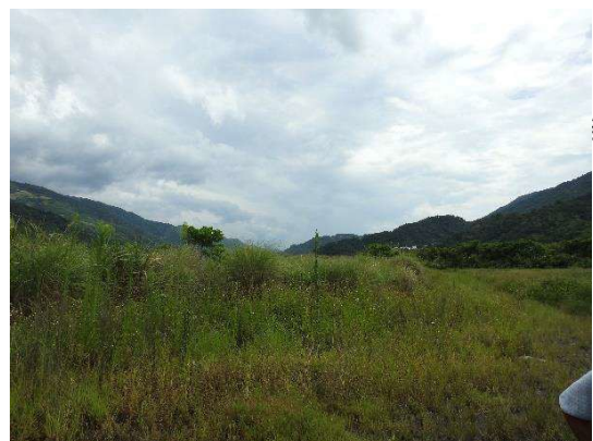
瑪崙堤防、瑪崙二號堤防開口處-高草莖草叢環境
