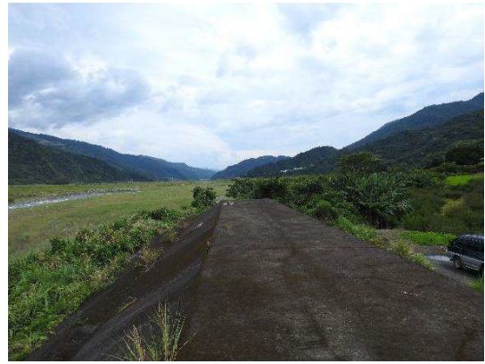
瑪崙一號堤防-混凝土構造物
