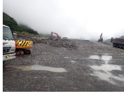
高灘地保護工採取 1:3 坡度
