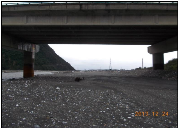
說明： 項目：水質 日期：102.12.24 (09:10) 地點：大濁水橋
