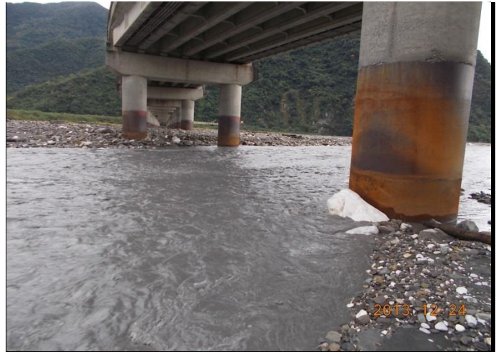
說明： 項目：水質 日期：102.12.24 (09:10) 地點：大濁水橋
