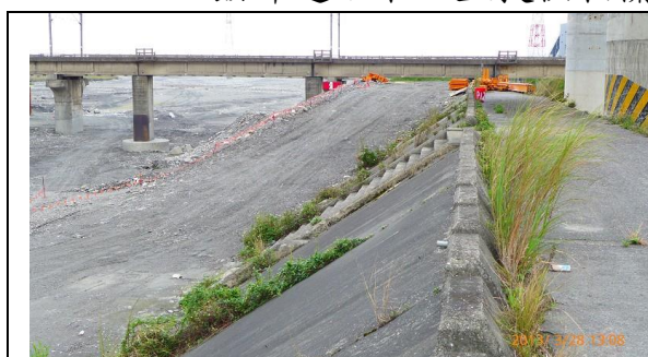
照片 6-57 和平堤防光滑水泥鋪面
