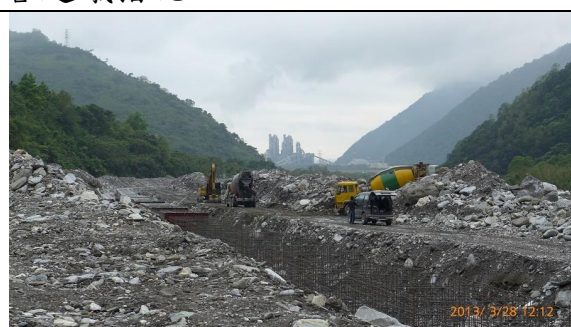
照片 6-58 楓溪工程阻礙生態廊道
