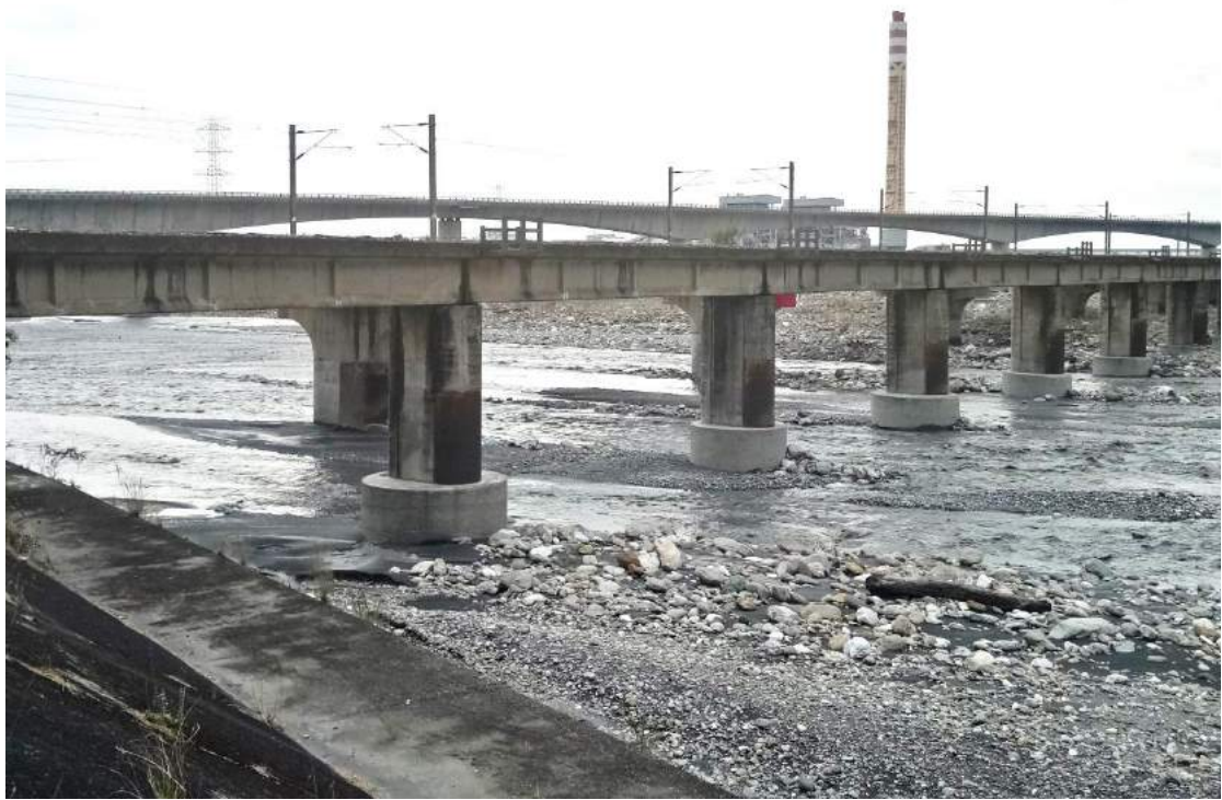
(c) 新、舊北迴鐵路橋
