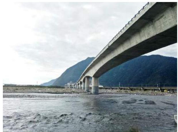
(b) 和平溪橋（蘇花改公路橋）
