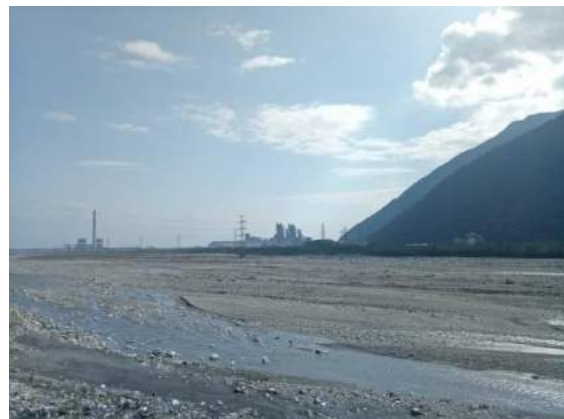
(b) 河口~大濁水橋-和平溪下游右岸
