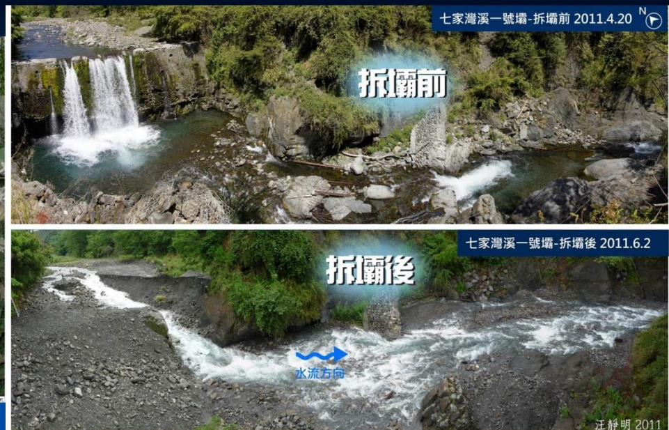
資料來源:汪靜明 2011 七家灣溪一號壩壩體及埤地改善工程-生態檢核評估及保育效益評析研究計畫 雪霸國家公園管理處
