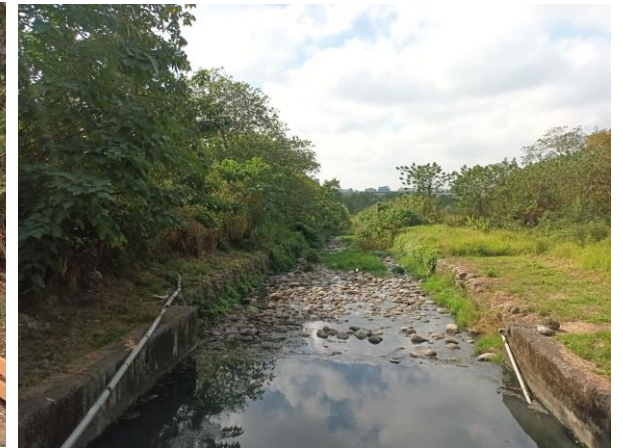
工區內排水溝
