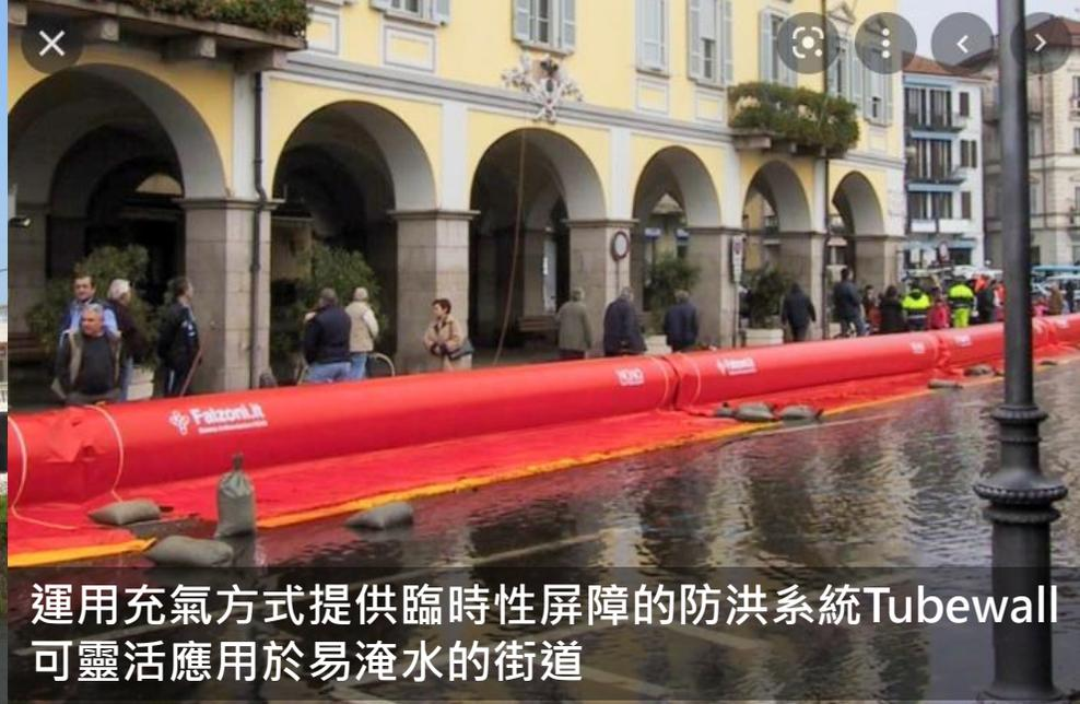
運用充氣方式提供臨時性屏障的防洪系統Tubewall
