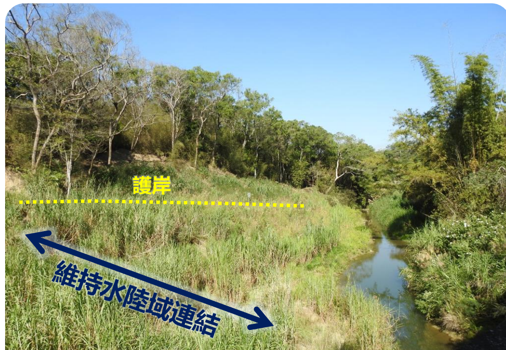
水保局案例：「北河村萬安橋上下游野溪整治工程」
