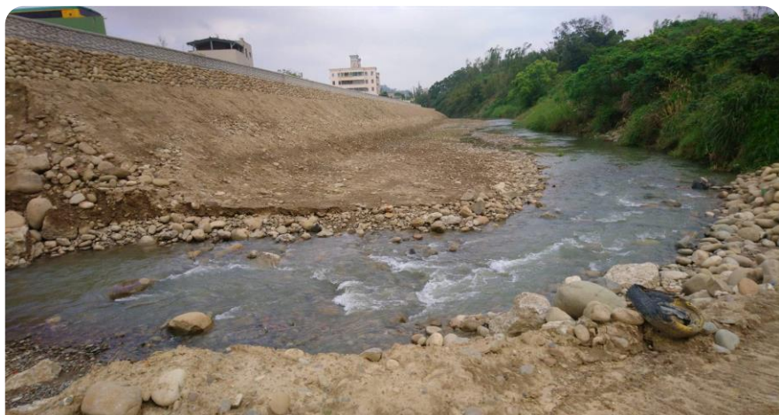
「沙河溪沙河橋改建工程」下游
