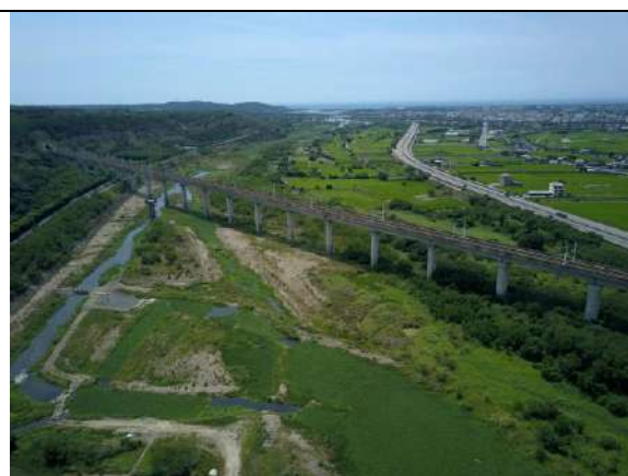
圖 2.6-11 後龍溪現況照片 (苗栗市新東大橋河濱公園)
