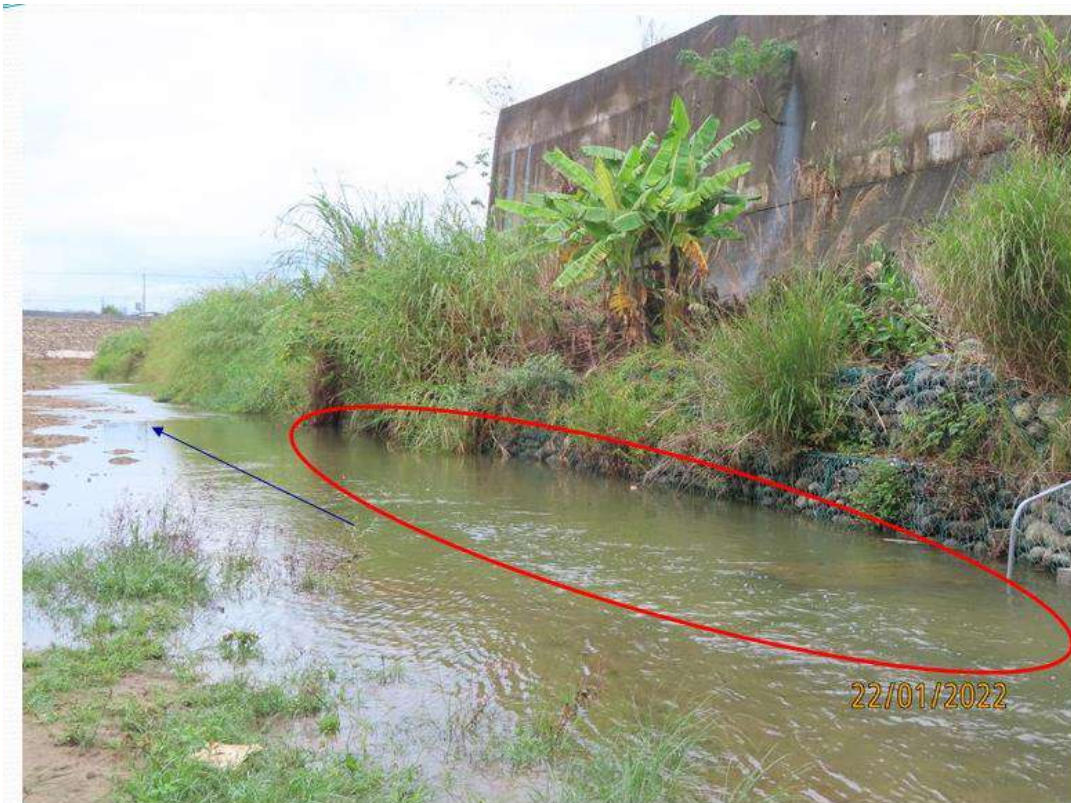
圖 3.3-4 沙河溪沙河橋上游水域概況圖
