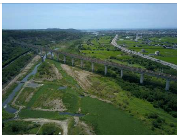
圖 2.6-4 後龍溪現況照片河道整理 後(跨渠構造物影響-高鐵橋)
