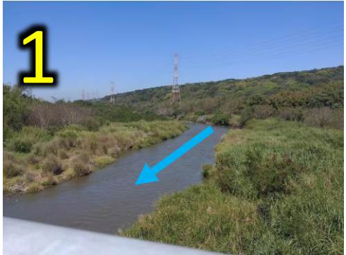
1 義民橋(河道現況)
