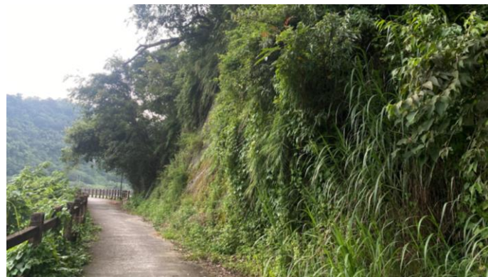
緊鄰道路之山壁
