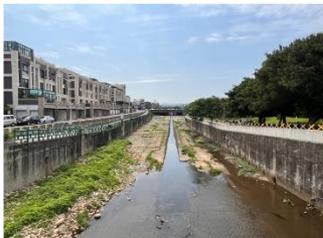
北勢溪河堤空間原貌像是大水溝，本次規劃將軟化水泥護岸，在低水行水流路上規劃彎曲的生態卵石護岸以及跌水工法，高灘處部分以親水步道及廣場配合硬質護岸，融合休閒與活動。
