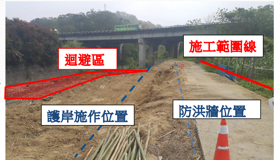
0K+664~0K+700 護岸施做位置圖 (本段取消施工)
