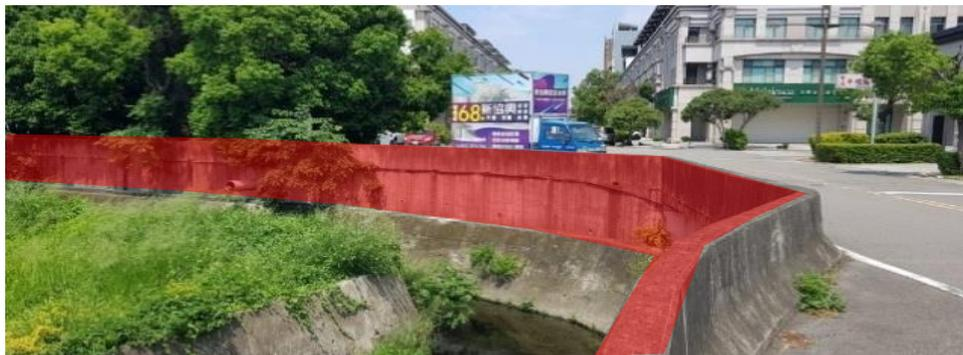
隆恩圳現況邊坡具有破損老舊之現像，且沿線的圍牆與欄杆型式容易造成外部空間與水岸空間分化，因此透過邊坡改善搭配**視覺穿透性佳欄杆型式**，虛化外部開放空間與水岸環境的隔閡，並配合**圳體自然化工程**，打造良好的水岸環境。
