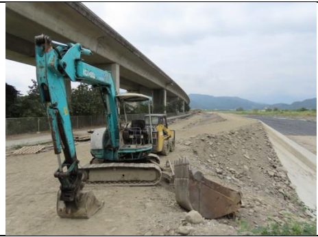
環境照-施工機具
