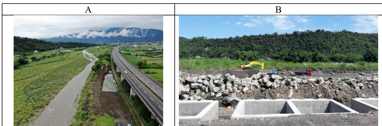
圖 3-10 眉溪房裡一號堤段施工現況圖
