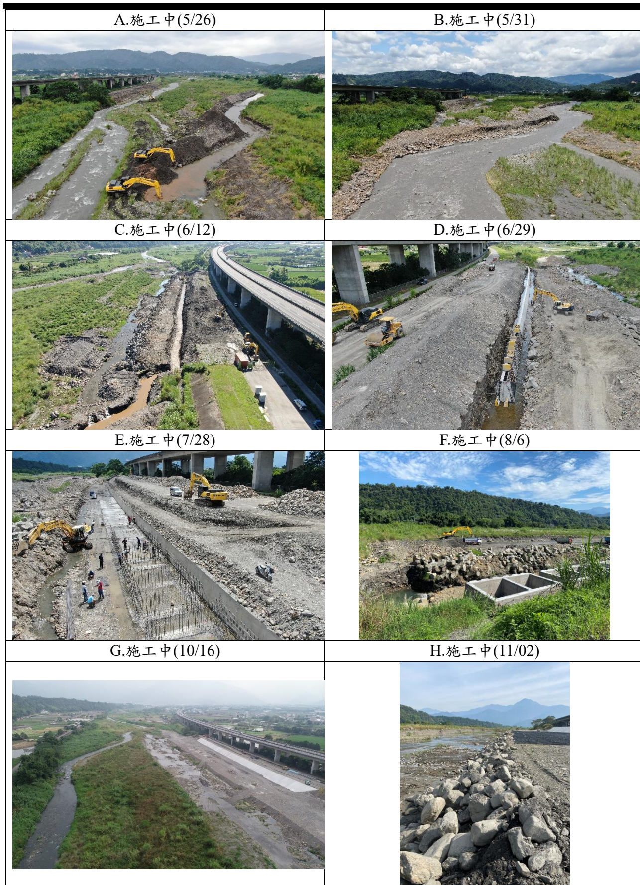
圖 3-11 眉溪房裡一號堤段勘查期間施工棲地影像紀錄
