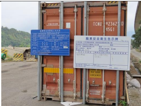
環境照-施工告示牌
