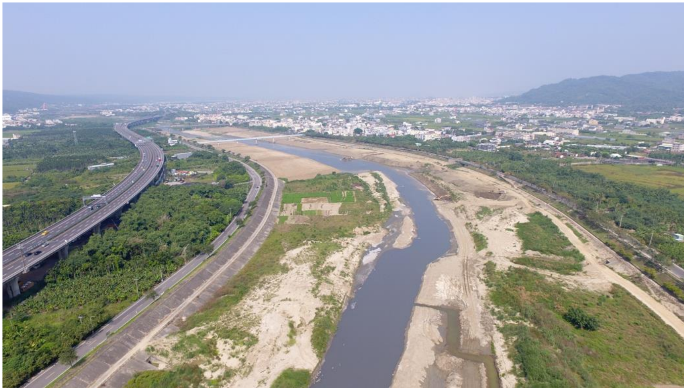
貓羅溪河道整理工程空拍照片(下游段南崗大橋以南)
