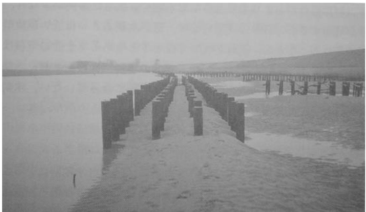
圖 4-27 椿式透水丁壩設置示意(本圖河川主要河床材料為砂，和本案情況並不相同，但椿工配置和淤積形態則類似。)
