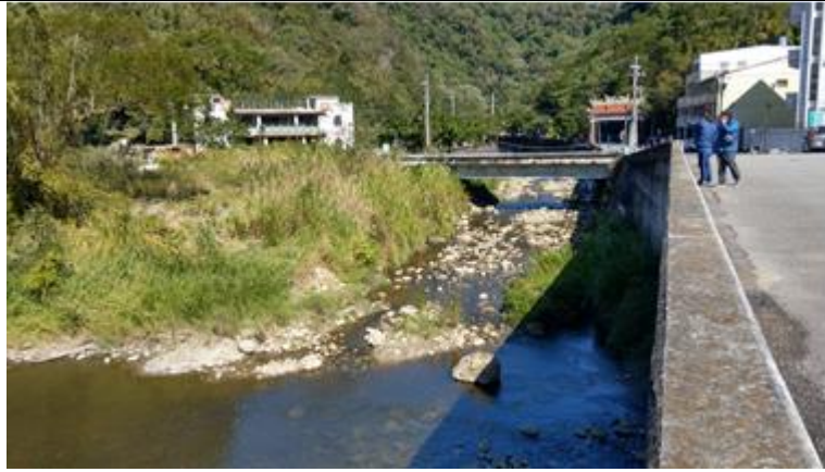
圖 3-7 預定治理區段之自然土坡影像照
