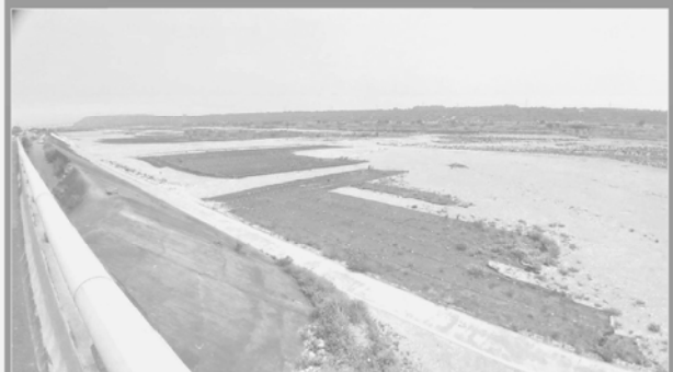
圖16. 續上，縱使築上護堤，還是不免被沖而岌岌可危， 只得一再藉由整理河道、培厚灘地而保護橋基， 所幸近幾年無豪大雨而暫能保住。 108-5-15
