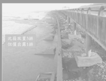
圖15. 橋墩基樁一再遭淘空 縱使堆置三排沈箱亦無效 國道四號神岡段6.6K處
