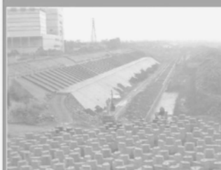
圖8. 續上，為免重蹈覆轍 原堤底旁另又加置沈箱
