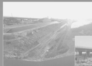
圖14. 原已有護岸，且未遭受沖擊，有必要再築堤防？ 大甲溪后豐大橋下游南岸
