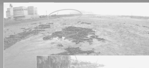
圖4. 后里舊社堤防屢遭淘空流失
