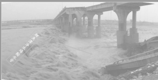
圖15. 橋墩基樁一再遭淘空 縱使堆置三排沈箱亦無效 國道四號神岡段6.6K處
