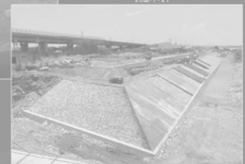
圖16. 續上，縱使築上護堤，還是不免被沖而岌岌可危， 只得一再藉由整理河道、培厚灘地而保護橋基， 所幸近幾年無豪大雨而暫能保住。 108-5-15
