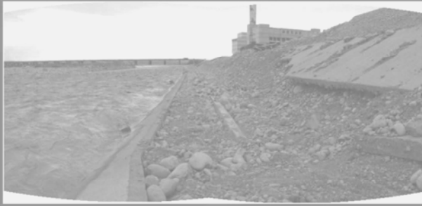
圖9. 續上 雖施作高規格之沈箱 但仍經不起梅雨考驗 96-6-15
