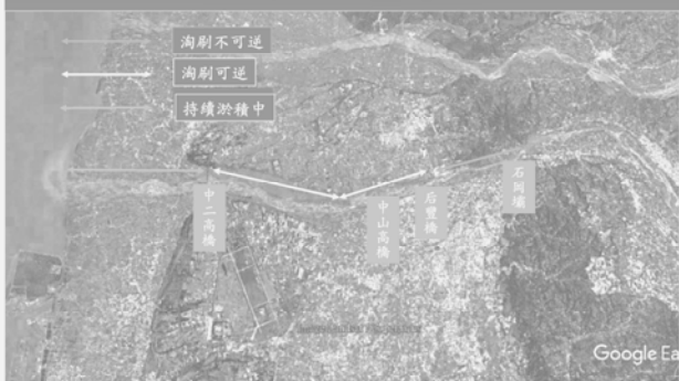
圖11. 石岡壩下游之淘刷日趨嚴重 Google earth 2016-12-31
