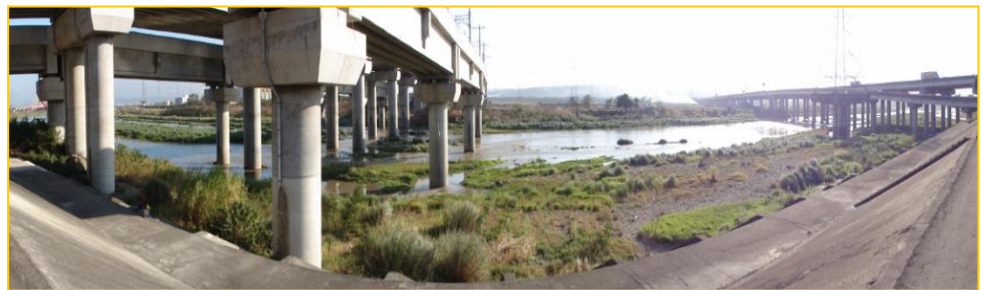
圖 1. 大里溪下游高鐵及中彰快速道二橋總共 10 列橋墩導致之淤積、阻流，勢必回頭加重烏日地區之水患，100-1-26。
