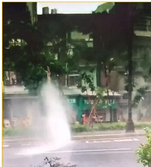
圖 9. 108 年 5 月 20 日下起一陣驟雨，綠川掀蓋段周邊排水溝之集水孔冒出不少水，慎防日後出現水患，在地居民何建宏攝。
