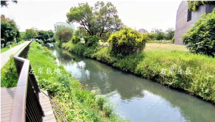
圖 4. 黎明溝右側之水泥護岸都能自長草木，何需耗費鉅資於左岸營造草皮？ 108-5-10。
