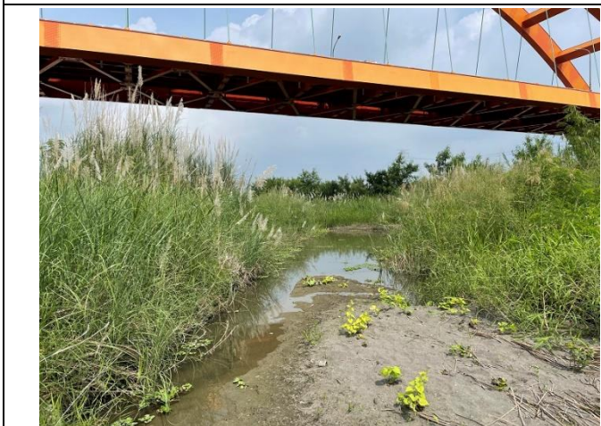
照片 15、2021/9/21 烏溪溪尾橋北岸的辮狀支流接近乾涸，此處有穩定的巴氏銀魴棲息。
