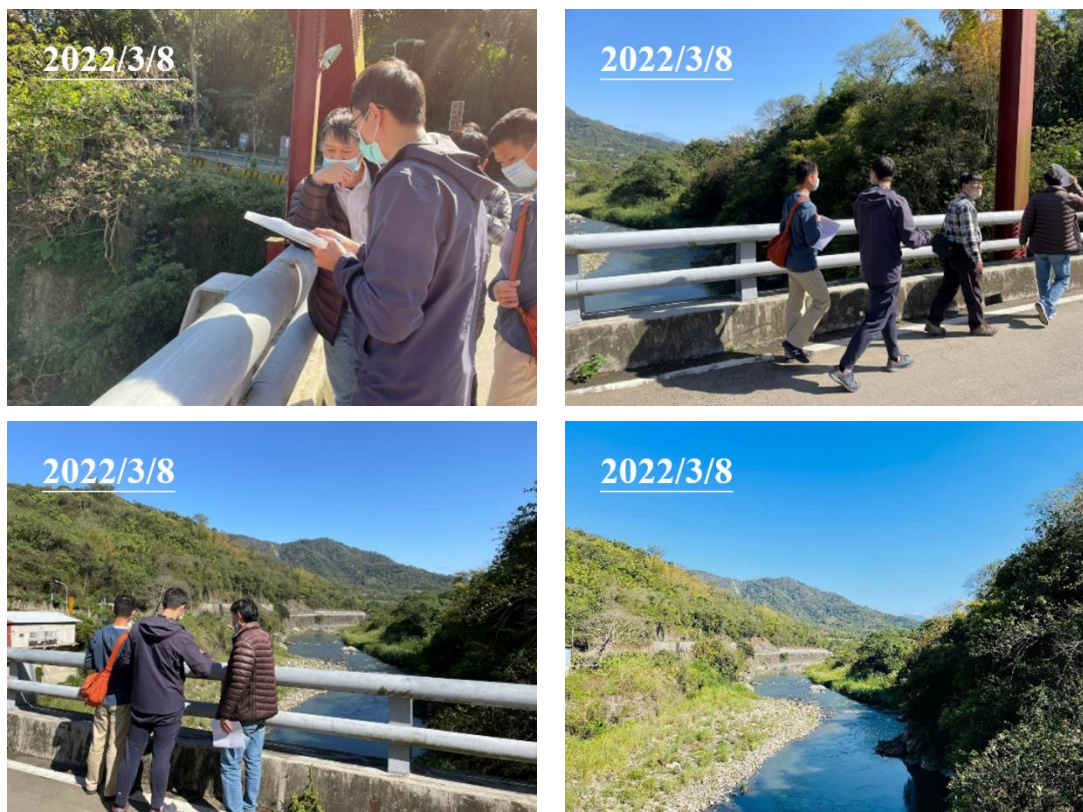
圖4-2 現地勘查紀實照片
