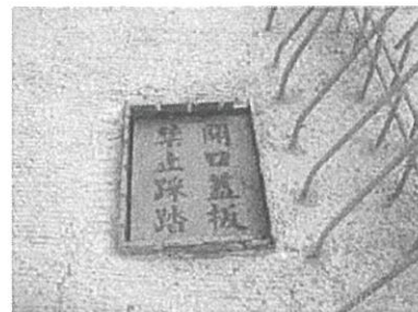
圖（二）洩水孔設置開口蓋板
