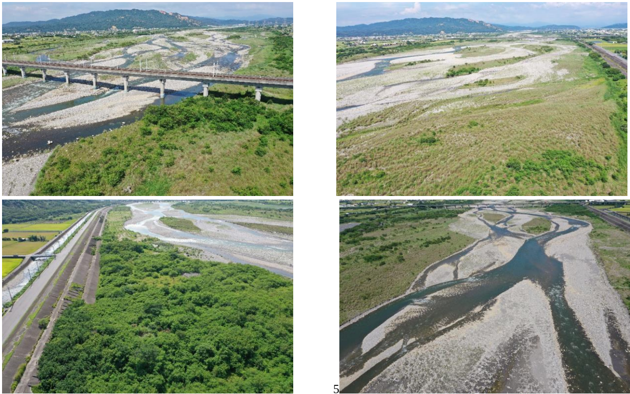
圖4-5 廊子堤防堤前現況(111/06/20)
