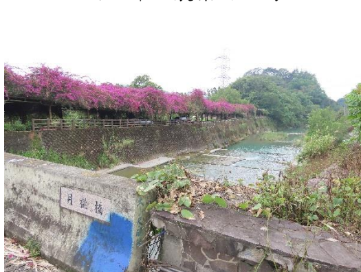
下游左岸設有植生涼亭
