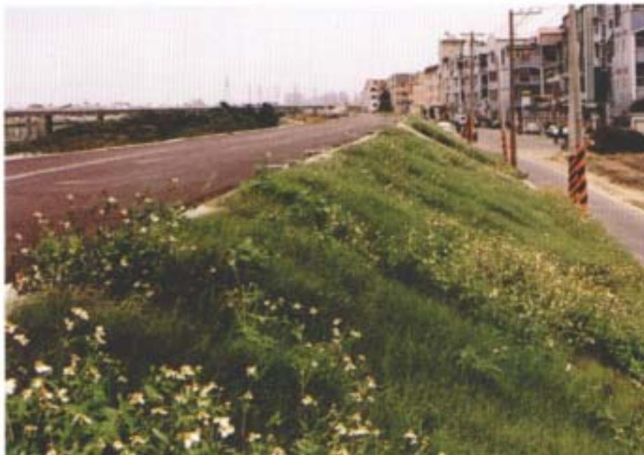
而大安溪現有堤防大多採 RC 鋪面，若進行綠美化改善工程使用與新建堤防相同之植草工程，其綠美化改善工程費偏高，每平方公尺直接工程費約 1,500 元，如改以植生網植生蔓藤於現有 RC 堤防表面，其綠美化之工程費較低，每平方公尺直接工程費約 250 元(如表 5.3-3)。故建議其綠美化工程採植生網植生蔓藤於現有堤防表面。
