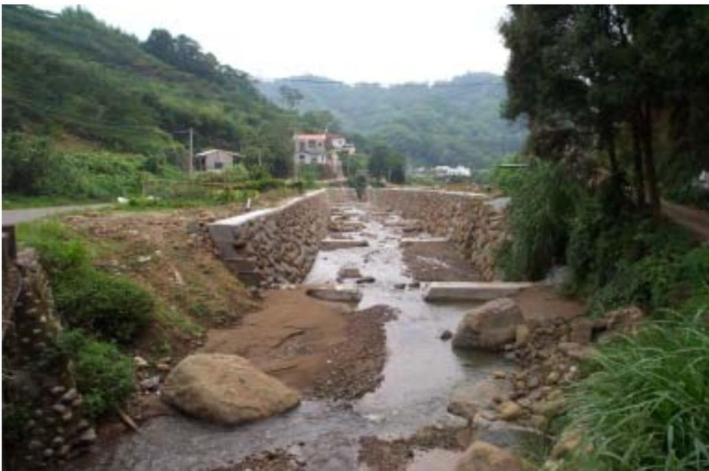
照片 3.1-12：觀音坑溪口塊石護岸施工狀況 2
