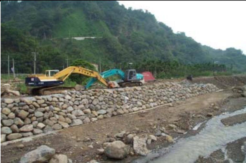
照片 3.1-11：觀音坑溪口塊石護岸施工狀況 1
