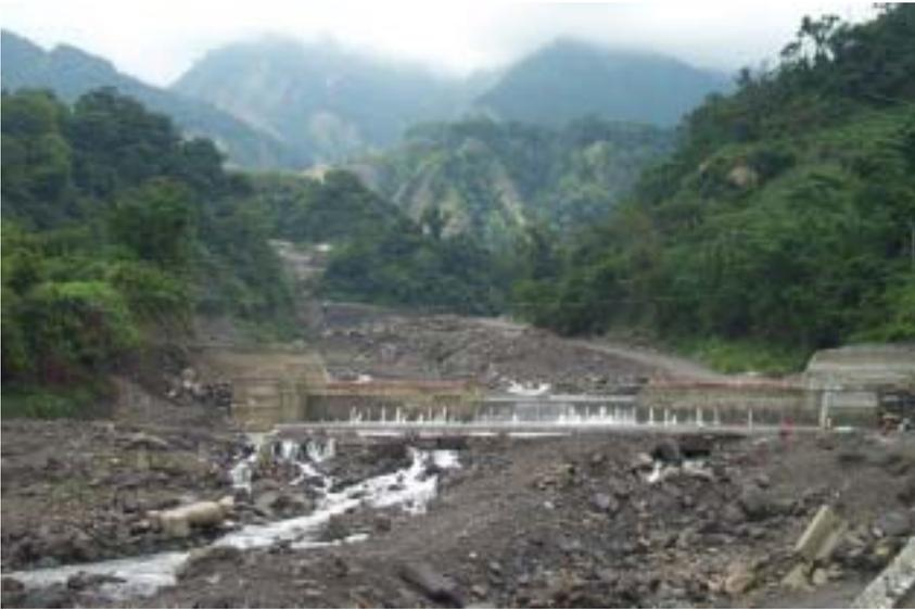
照片 3.1-3 烏石坑溪吊橋下方新建防砂壩
